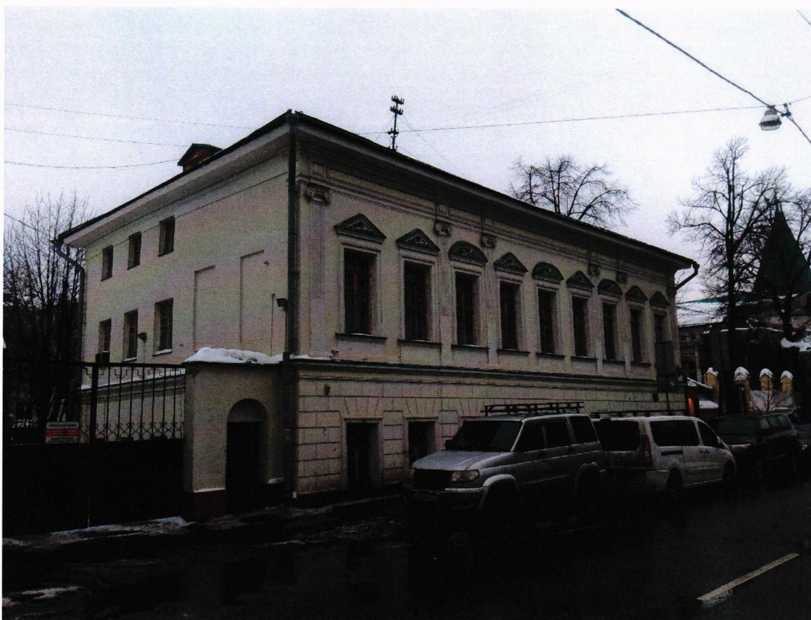
Фото № 1. Северный и западный фасады дома № 29 по улице Бахрушина.
