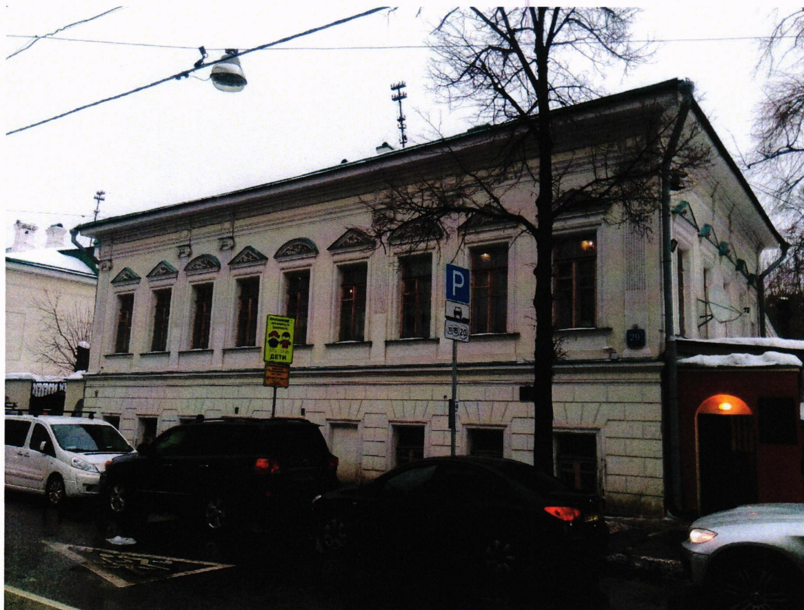
Фото № 2. Южный и западный фасады дома № 29 по улице Бахрушина.
