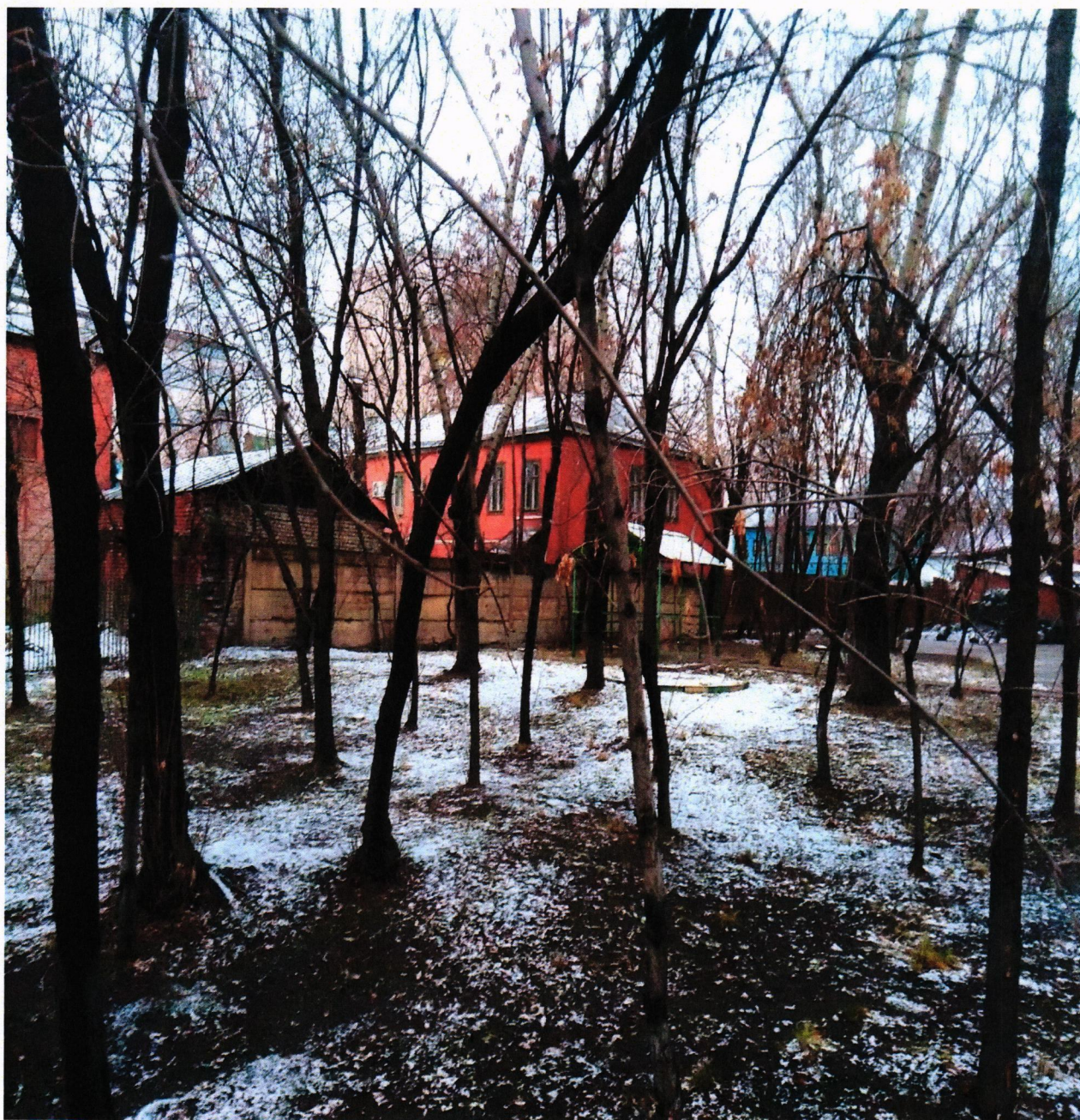
Фото № 5. Южный и восточный фасады строения 2 дома № 31/12 по улице Бахрушина.
