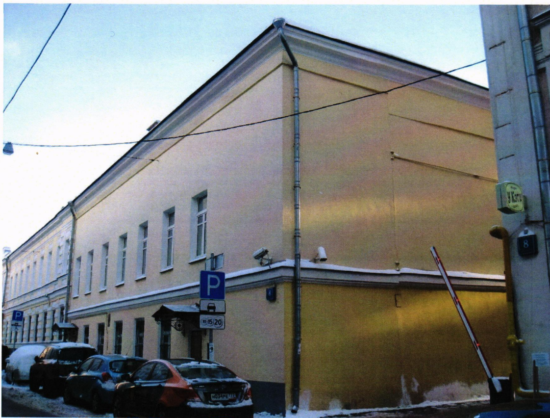
Фото № 2. Вид на фасад со стороны Сеченовского пер.
